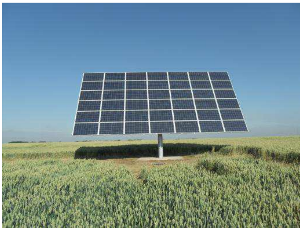
Rysunek 10. Przykładowy tracker zawierający 42 panele fotowoltaiczne
