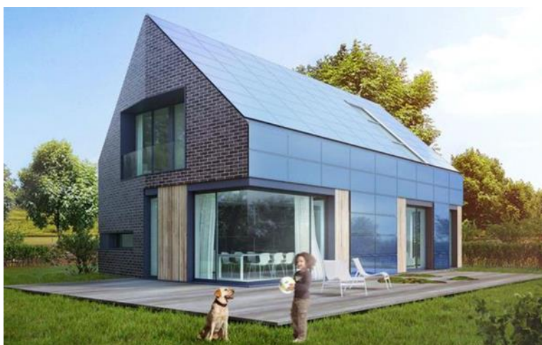
Zdjęcie 3 Fotowoltaika jako fasada budynku jednorodzinnego
